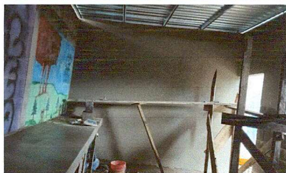
Foto 4: Reparación de repello y cernido de paredes.
