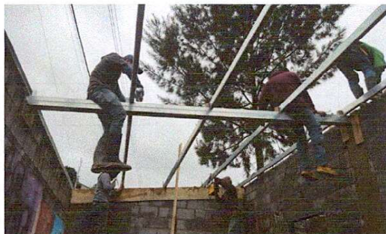
Foto 2: Cambio de costaneras.
