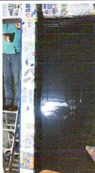
Foto 3: Cambio de puertas por deterioro.
