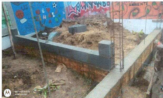
Foto 4: Sustitución de paredes de cocina según acta de opf.
