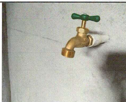
Foto 2: Reparación de red de agua por deterioro.
