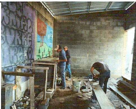
Foto1: Reparación de repello y cernido de paredes.
