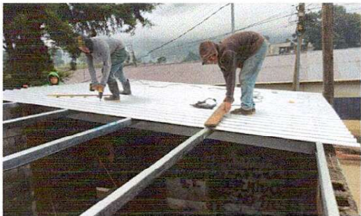
Foto1: Colocación del techado
