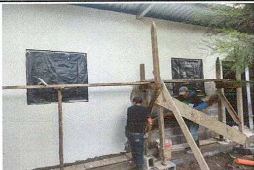
Foto 5: Aplicación de monocapa blanca
